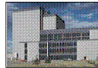
FORT ST. VRAIN 842 MWt prismatic 750°C (USA) 1976-1989
